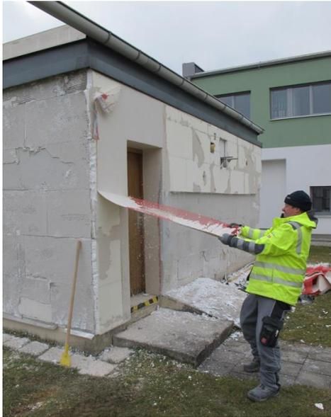
Abbildung 86: Abschälen der Decklage aus Putz und Gewebe (Bildnachweis IBP)
