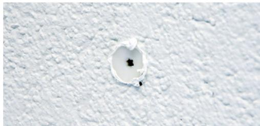
5 Überschüssige Fugenklebedichtmasse zwischen Putz und Spiraldübel entfernen
