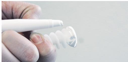
3 Fugen-Klebedichtmasse unter Dübelteller auftragen
