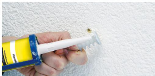
2 Fugen-Klebedichtmasse zur Abdichtung verwenden
