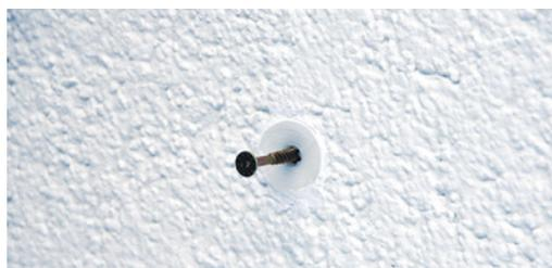
6 Mit 4 – 5 mm Schraube Anbauteil befestigen
