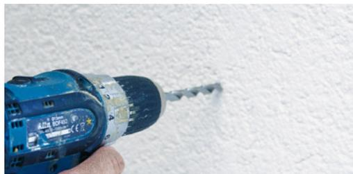
1 Verputzte Holzfaser-Dämmstoffplatte mit 8 mm-Holzbohrer vorbohren
