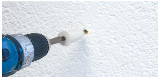
4 Spiraldübel oberflächenbündig mit verputzter Holzfaser-Dämmstoffplatte eindrehen
