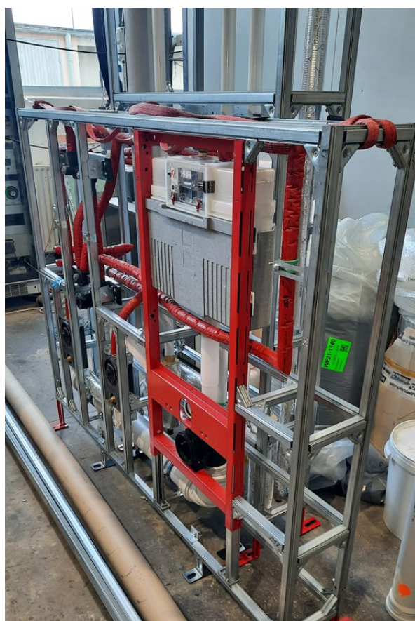
Offene, noch unverbundene TECEprofil-Tragwerke des Installationsschachtes (Hintergrund) und der teilhohen Installationswand (Vordergrund)
