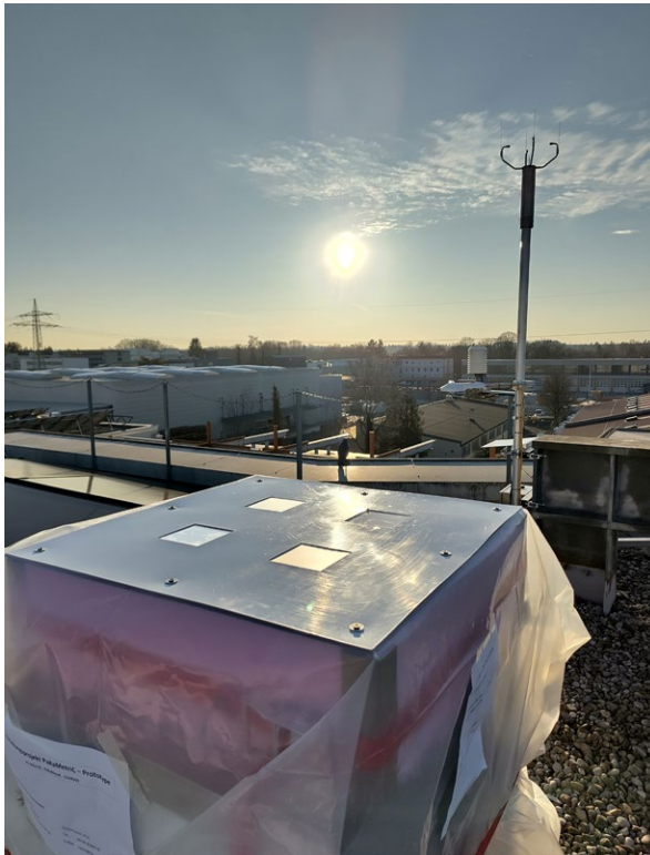
Prototyp zur Materialcharakterisierung auf dem FIW-Dach samt Messequipment.
